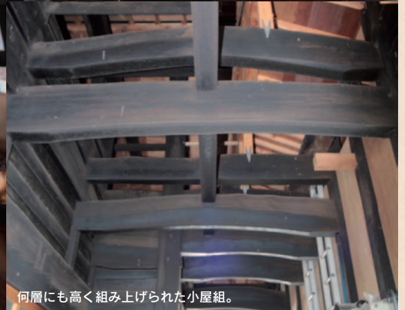
梁、鴨居、敷居、床にアカマツが使われています。
