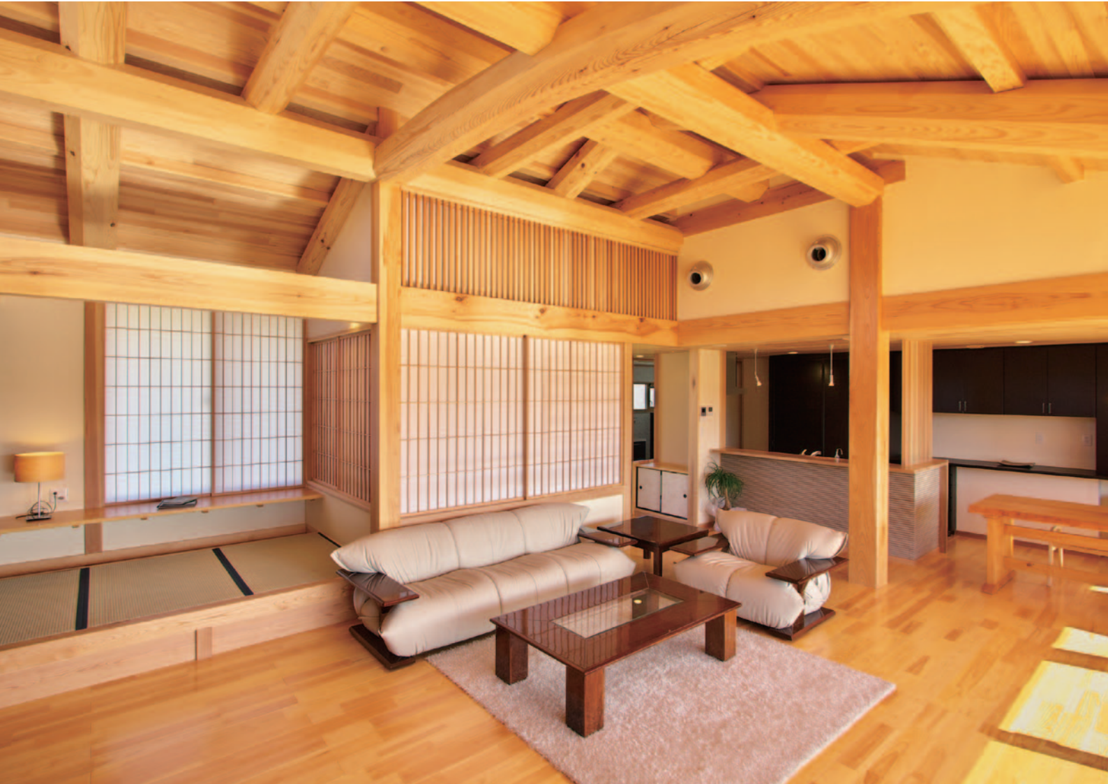
登り梁、胴差、通し柱、床板にアカマツが使われています。
